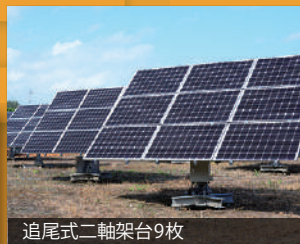
追尾式二軸架台9枚
