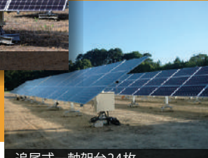
追尾式一軸架台24枚
